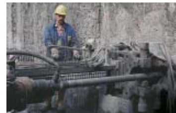
Uitvoering van de Soilfrac®-boringen
