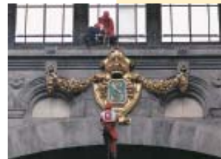
Installatie van een scheurmeter
