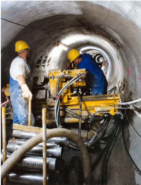
▲ Arbeiten im Medienkanal
