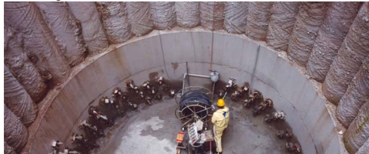
▲ Verpressarbeiten aus einem Schacht
