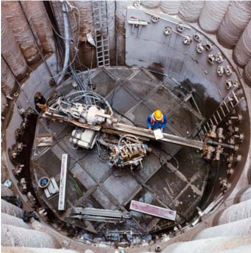
▲ Blick in einen Arbeitsschacht
