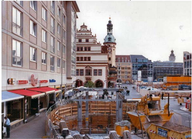
▲ Einer der 13 Schächte entlang der Trasse
